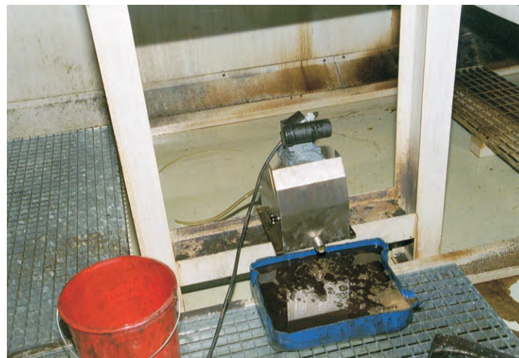
Déshuiler à tuyau à réservoir traitant de l'émulsion
