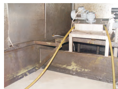
W40 dans une station d'épuration
