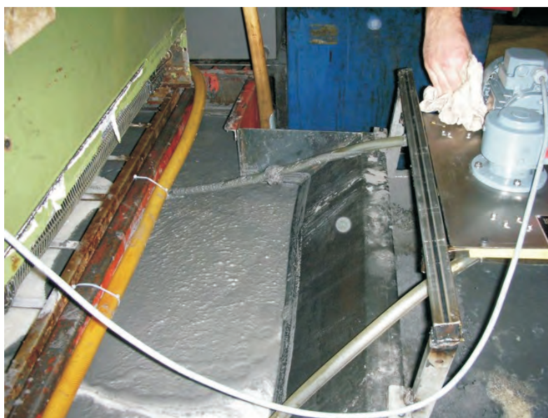
Déshuileur à tuyau W40 sur bassin de refroidissement
